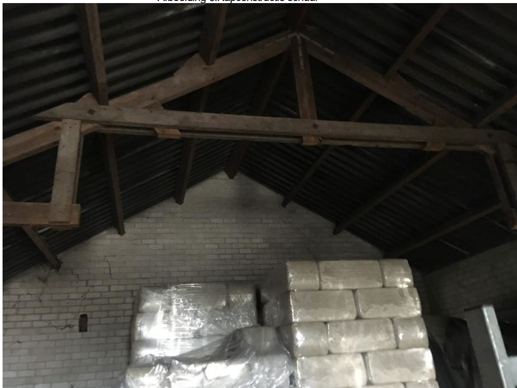
• Afbeelding 6: Kapconstructie schuur
