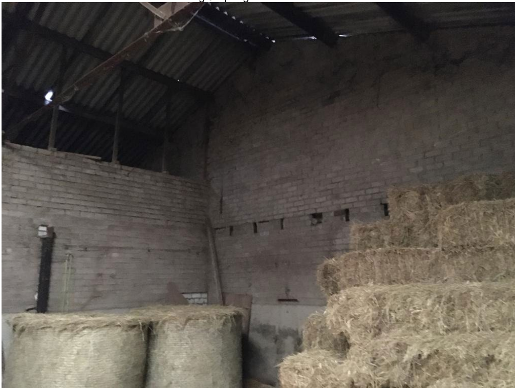
• Afbeelding 8: opslag hooi en stro in schuur
