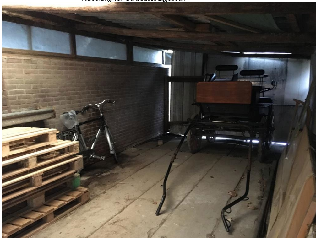
• Afbeelding 16: Constructie zijgebouw
