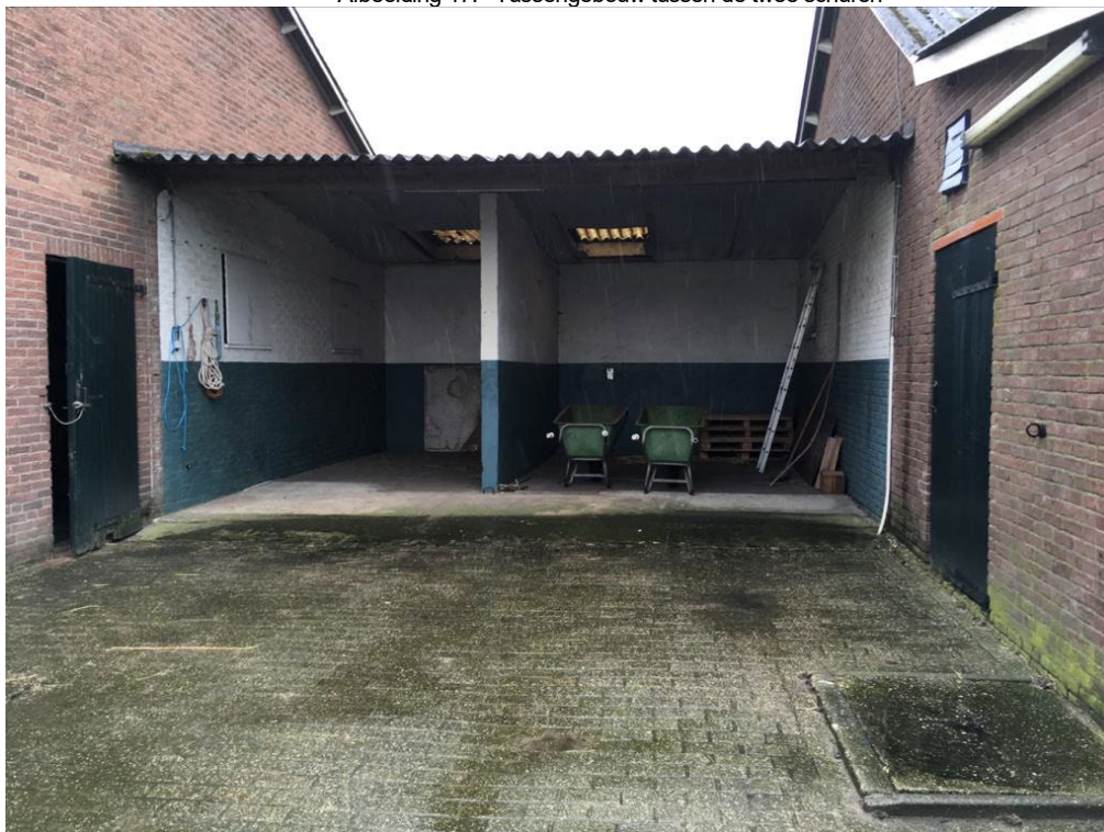
• Afbeelding 17: Tussengebouw tussen de twee schuren
