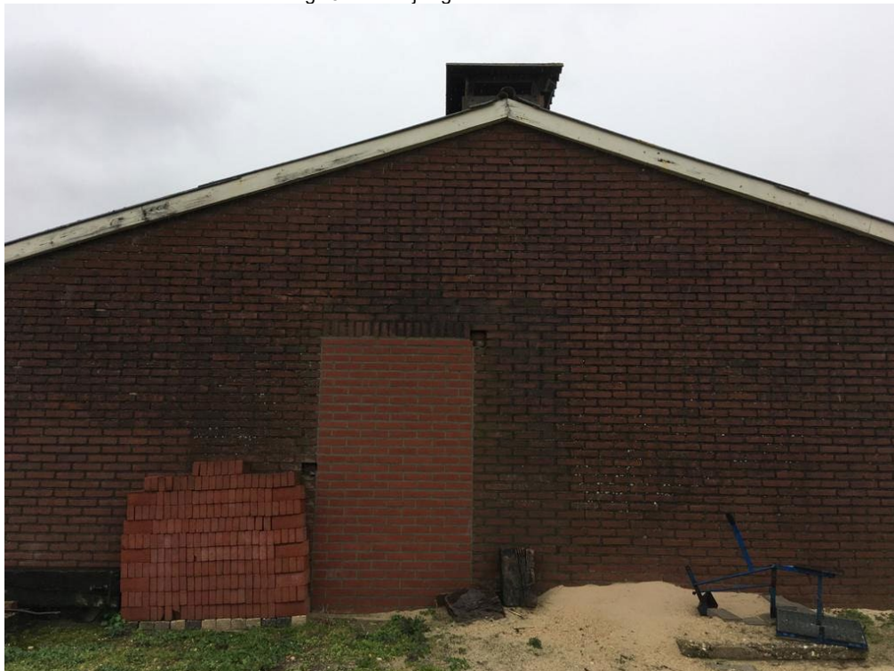
• Afbeelding 15: Achterzijde gevel schuur
