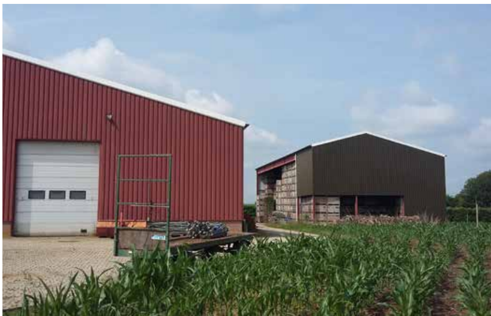
Te slopen schuren gezien vanuit het oosten.
