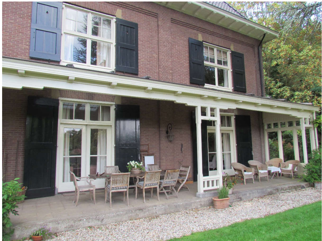
Rechter zijgevel met veranda
