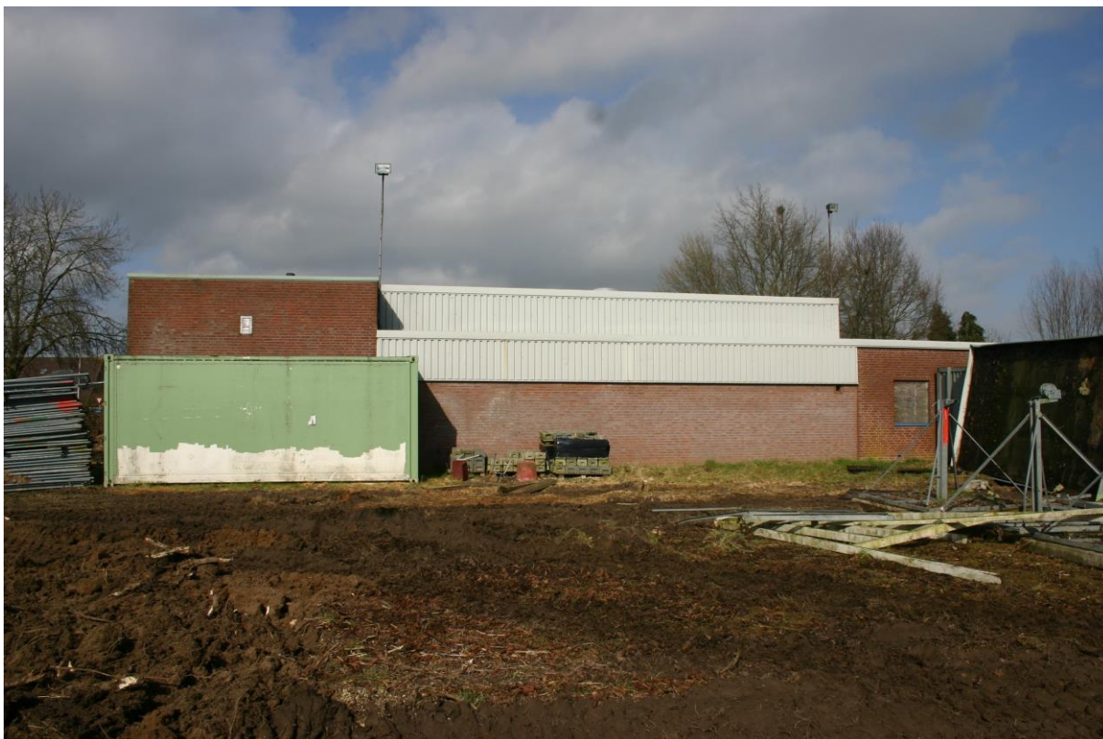
Figuur 2. Zicht op het te slopen gebouw.
