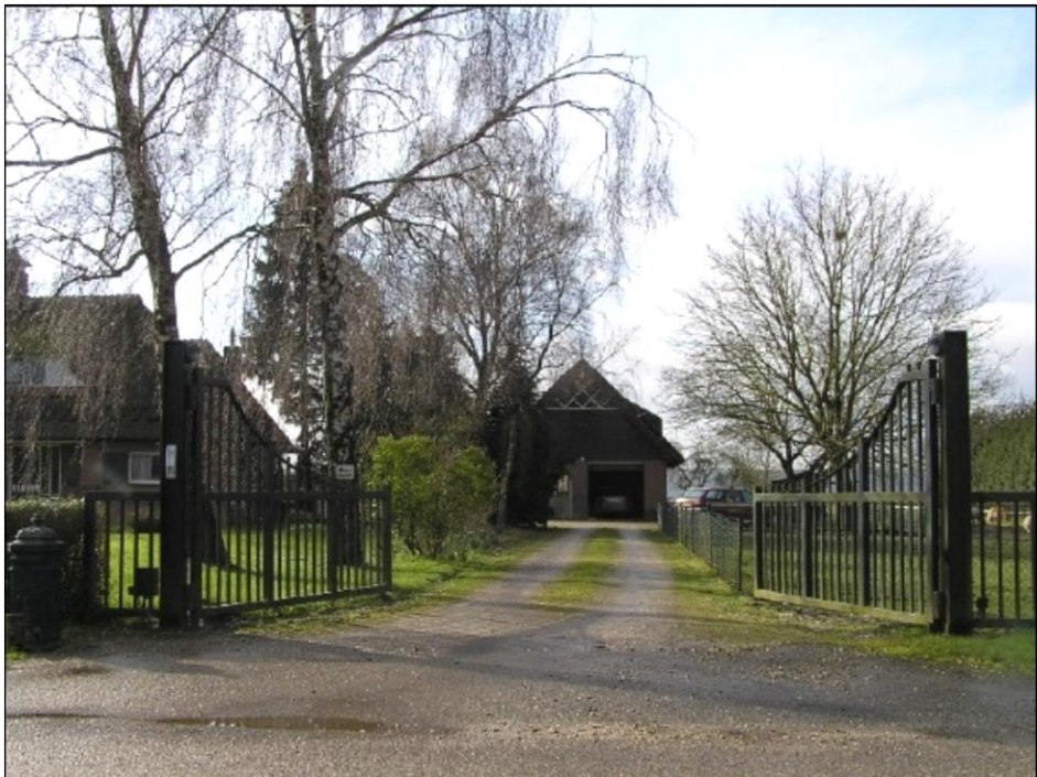
Foto 2: Huidige inrit voor bedrijfswoning en bijgebouw van bedrijfswoning
