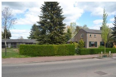
De locatie Hoge Horst 25, rechts de woning en links het braakliggende stuk grond, gezien vanaf de weg
