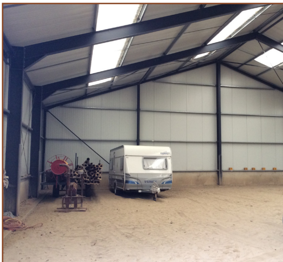
Afb. 2.6: Binnenkant manege. De hal is volledig ontoegankelijk voor vogels, vleermuizen en andere dieren.
