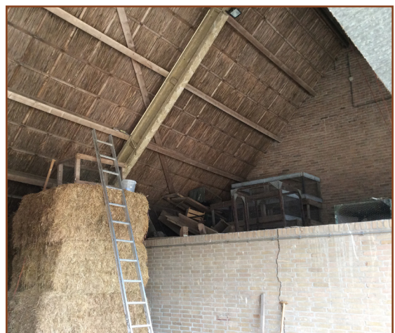
Afb. 2.5: Binnenzijde kapschuurgedeelte van de westelijke stal. Duidelijk te zien is het rieten dakbeschoot. Uilen maken geen gebruik van de schuur, wel broedt er een Soepeend en dienen de balken als slaapplek voor duiven.
