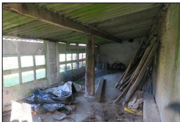
Foto 12. Materialen in te slopen bijgebouw
