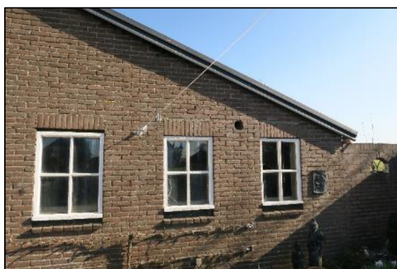
Foto 5. Voorkant caravanshuur van gat in de muur
