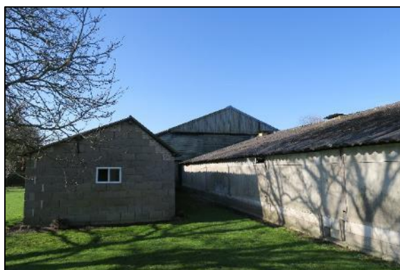
Foto 1. Oostzijde te slopen gebouwen
