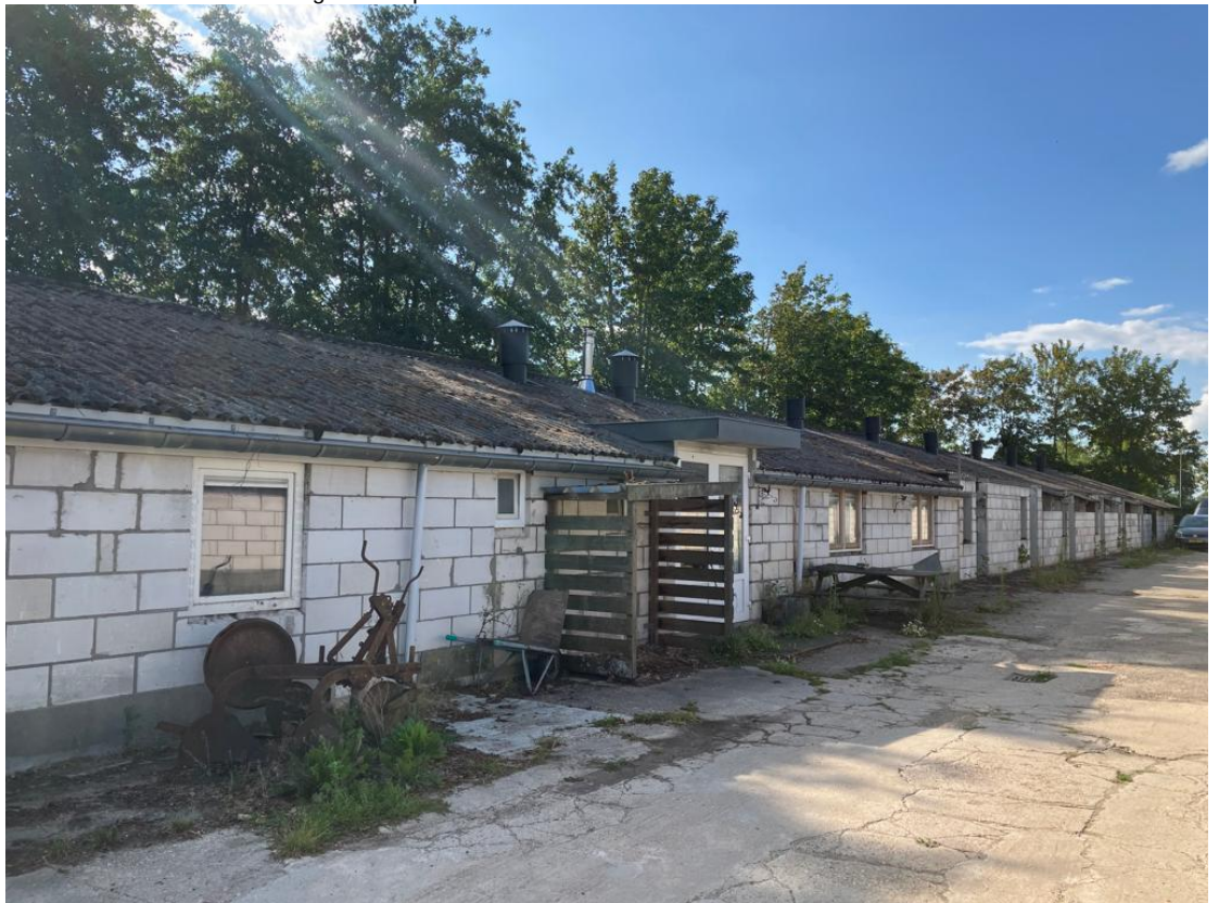
• Afbeelding 6: Te slopen schuur
