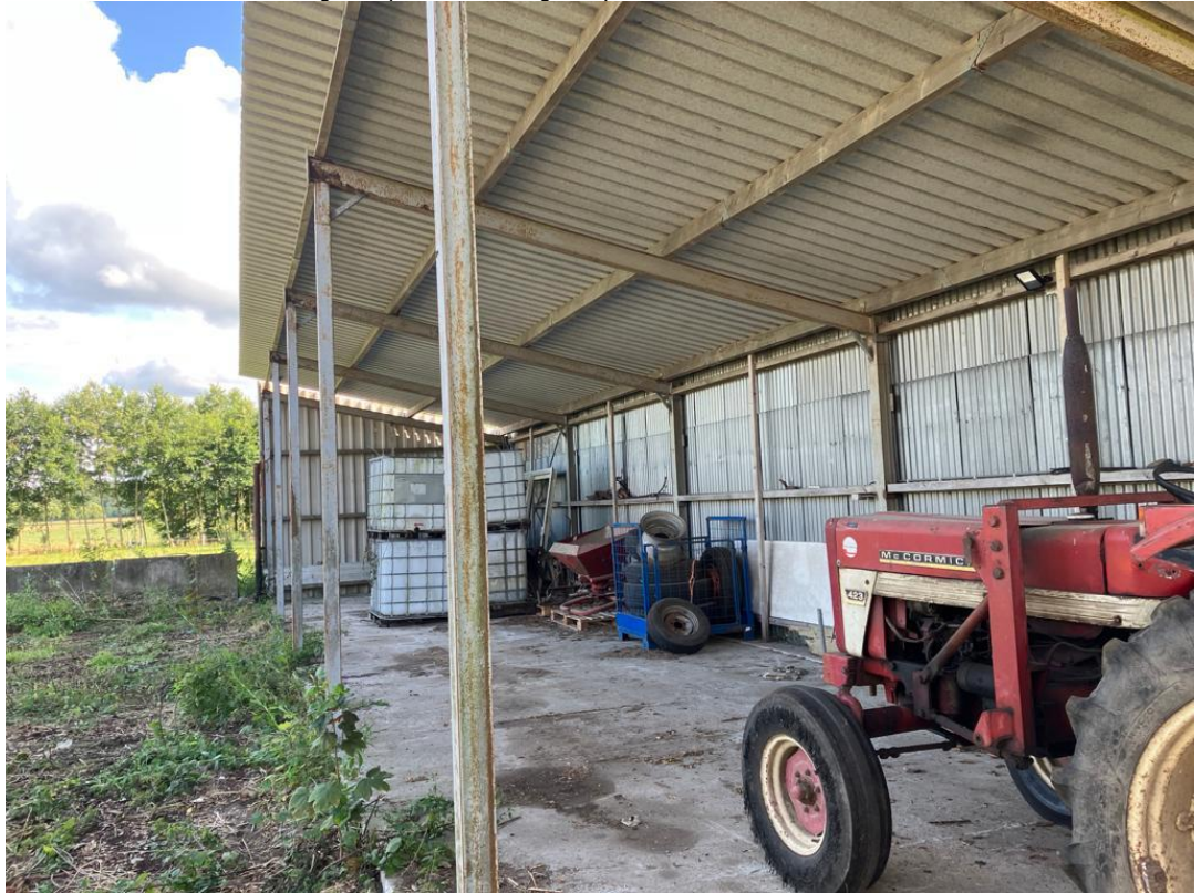
• Afbeelding 9: Kapschuur, wordt gesloopt
