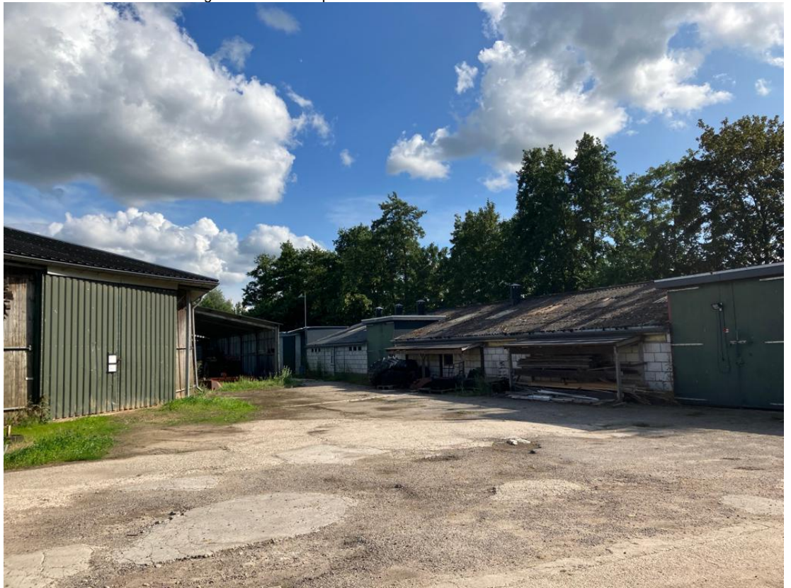
• Afbeelding 5: Aanzicht te slopen schuren
