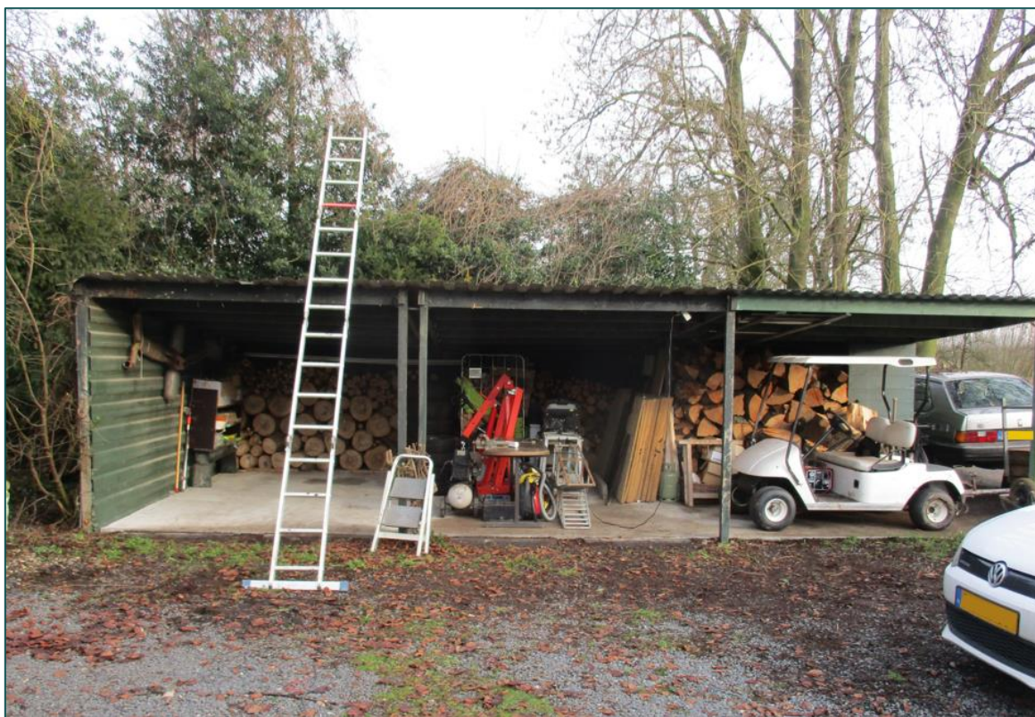
Figuur 1 De te slopen carport.
