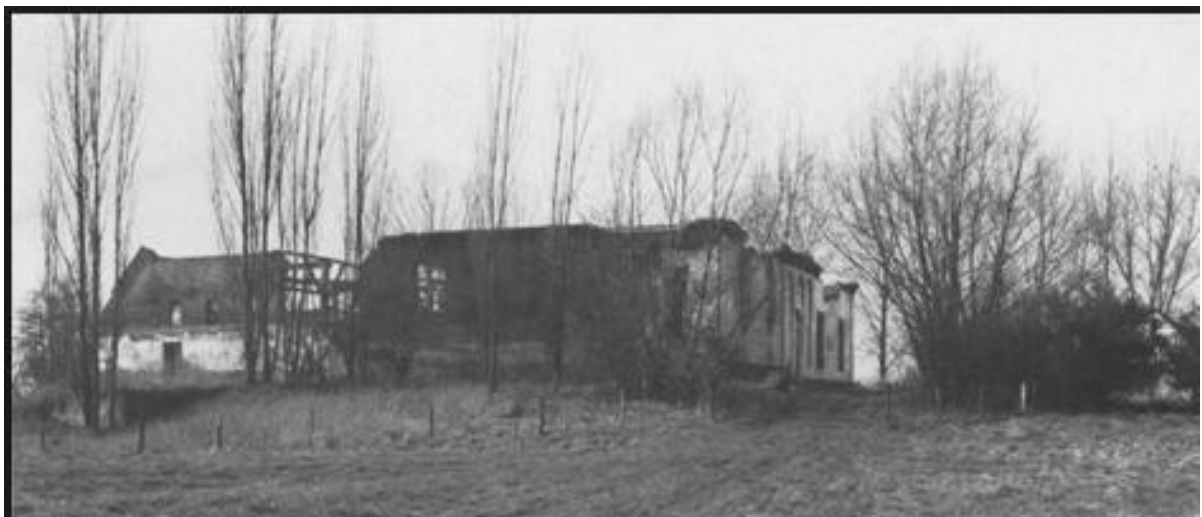
Afb. 12: Huis en schuur na de brand omstreeks 1980 RCE Beeldbank
