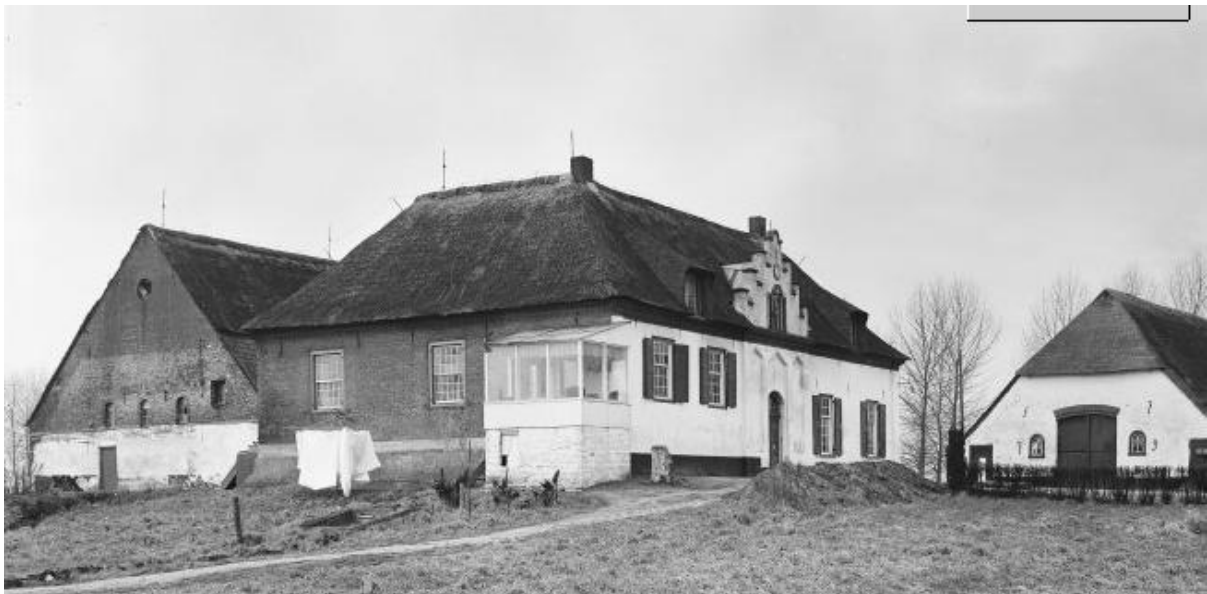
Afb. 7: Het complex in 1970. Foto A.J. van der Wal RCE Beeldbank
