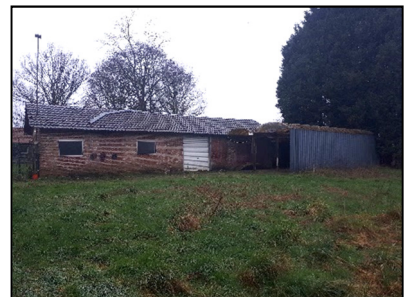
Figuur 5. Een van de schuren op het perceel.
