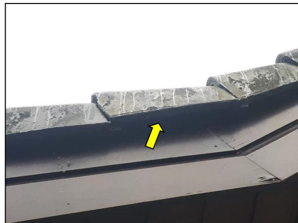
Figuur 13. Ruimte onder dakpannen woonhuis.
