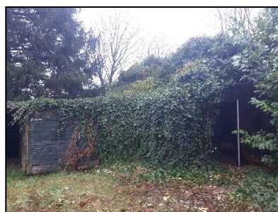
Figuur 4. Een van de schuren op het perceel met klimop overgroeid.
