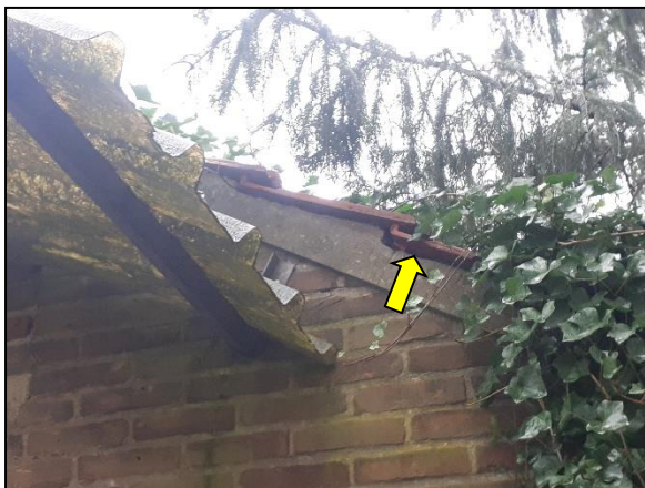
Figuur 12. Ruimte onder dakpannen schuurtje.
