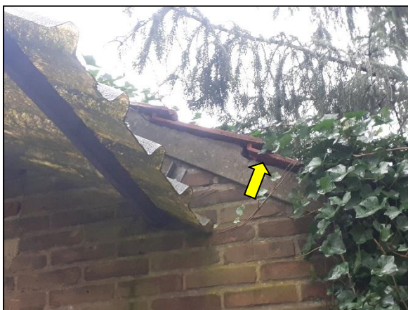
Figuur 10. Toegang onder losliggende dakpannen.
