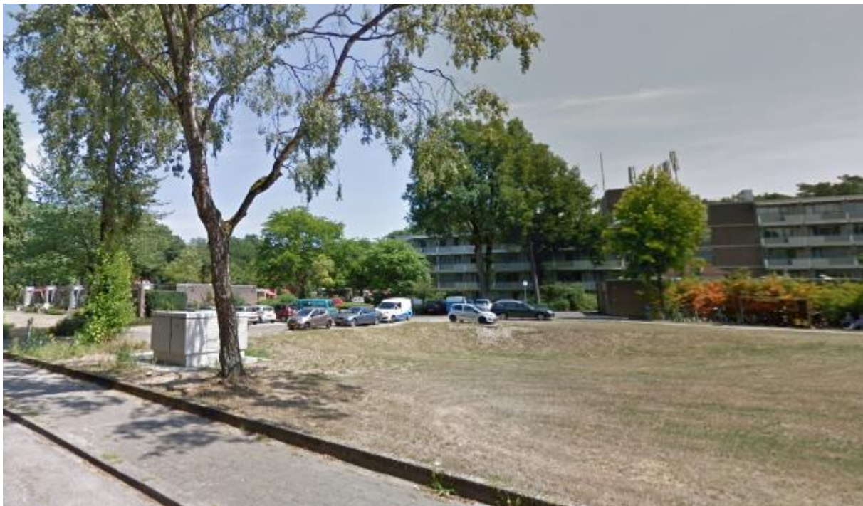
Figuur 2.1 Het plangebied in de huidige situatie met links de patiowoningen en rechts een flatgebouw (bron: Google Streetview)
