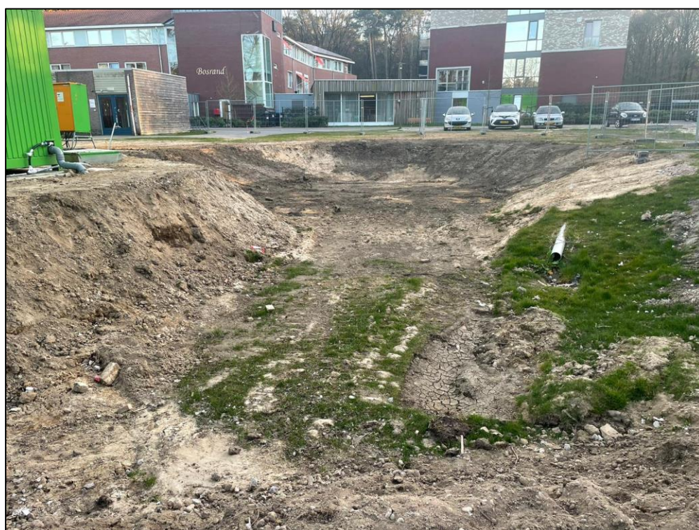
Figuur 5. Foto van de gegraven wadi in het westelijk deel van het plangebied (Foto: 16 maart 2022).
