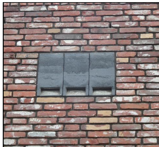
Doorsnede Ingemetselde vleermuisvoorzieningen Buitenaanzicht inpandige voorzieningen.
