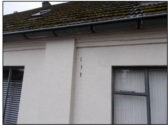
Figuur 7. Open stootvoegen
