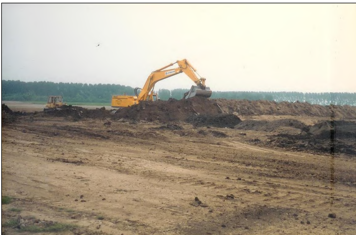
P02417_NOB_03: Naoorlogse kleiwinningsactiviteiten het plangebied waarbij de grond na de winning weer wordt aangevuld en vlak gezet. Om deze reden verschillen de maaiveldhoogten niet op de in paragraaf 4.3.4 behandelde kaartvergelijking.
