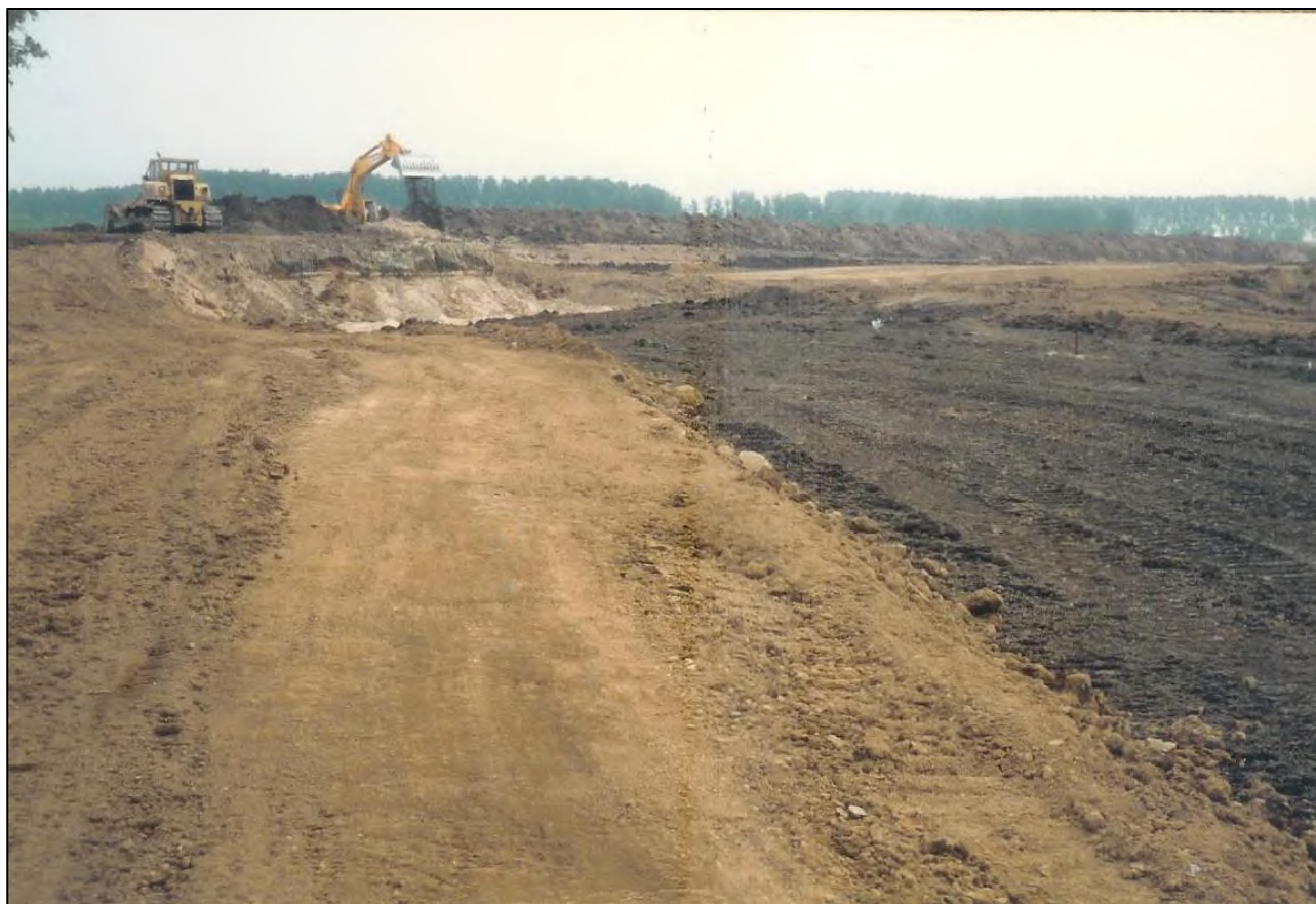
P02417_NOB_01: Naoorlogse kleiwinningsactiviteiten het plangebied. Te zien is dat met zwaar materieel de bovenste kleilaag tot op enkele meters diepte wordt afgegraven.
