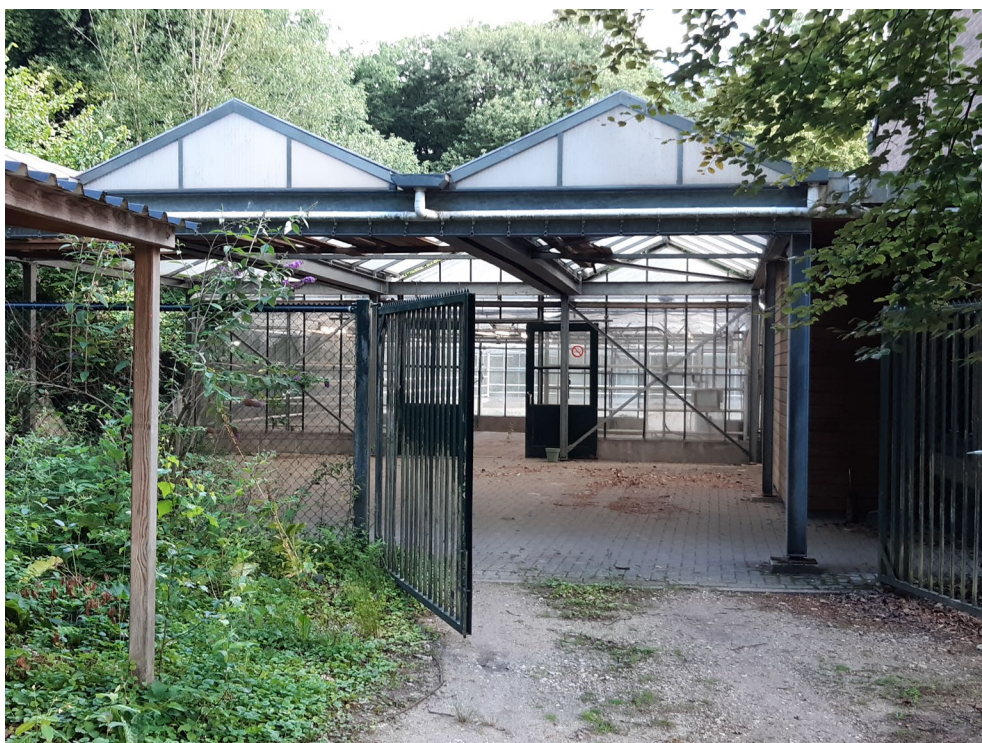
Kas zoals aanwezig ten noorden van gebouw Dominee J.A. Visscherlaan 4a
