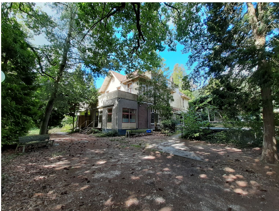
Gebouw Dominee J.A. Visscherlaan 1
