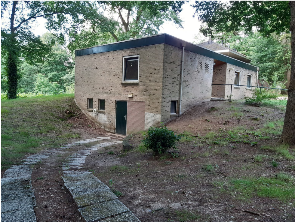
Gebouw Dominee J.A. Visscherlaan 3
