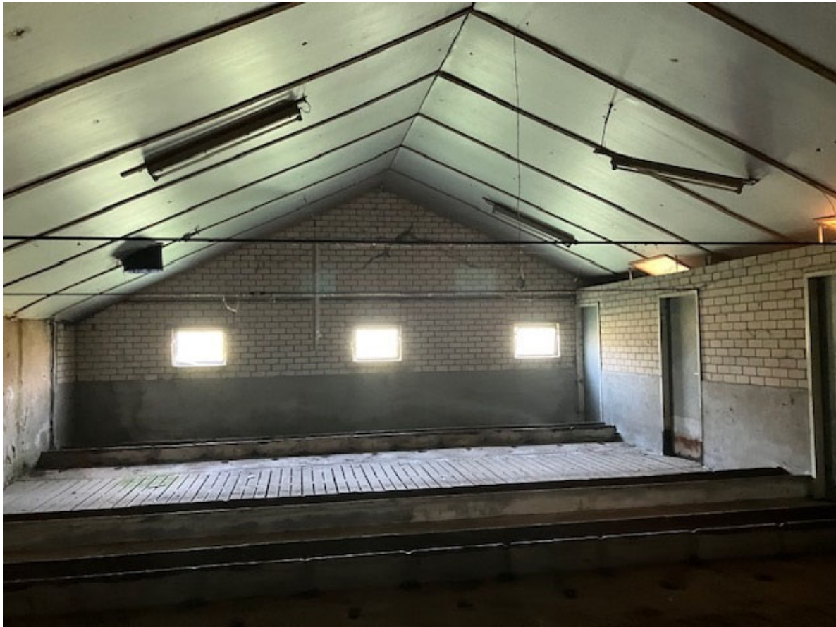
• Afbeelding 15: Binnenzijde voormalige varkensstal wordt gesloopt
