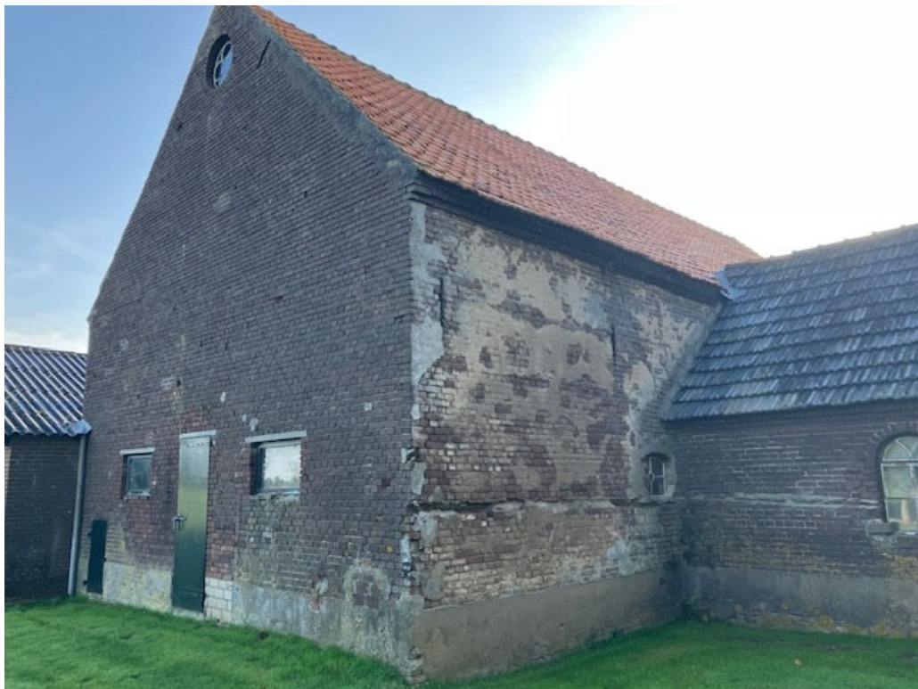
• Afbeelding 7: Voorgevel oude schuur, blijft behouden
