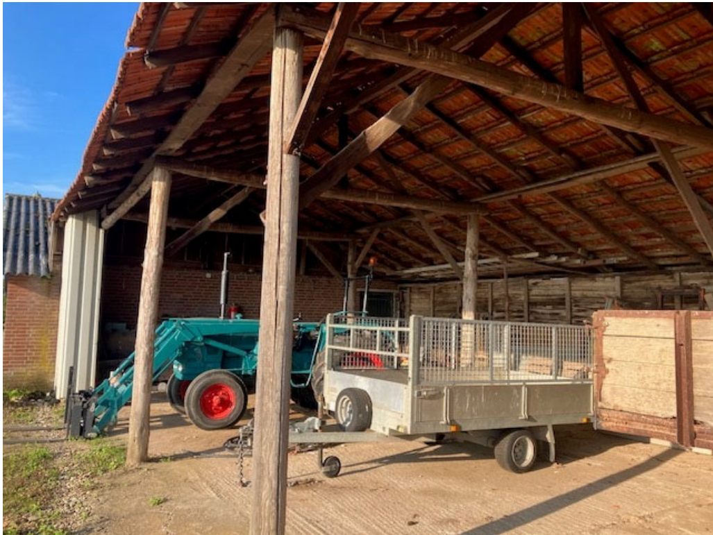
• Afbeelding 12: Onderzijde veldschuur
