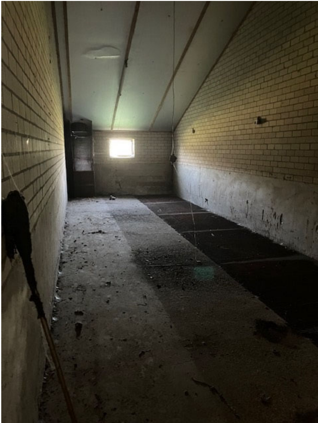
• Afbeelding 16: Binnenzijde voormalige varkensstal wordt gesloopt
