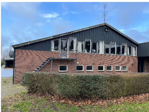
De buitengevel van het manegebouw vormt een potentiële verblijfplaats voor vleermuizen.
