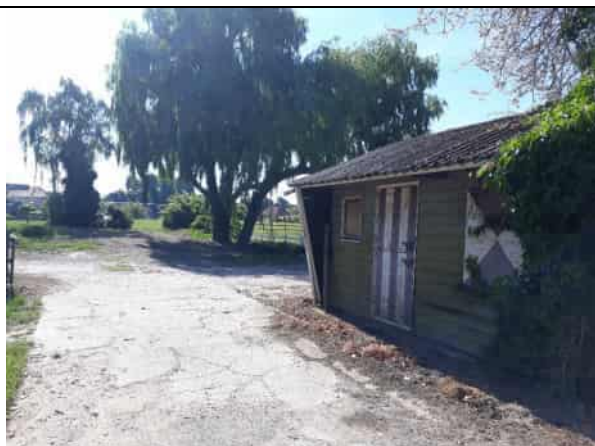
Begroeiing tegen barak met asbestdak zonder dakgoot
