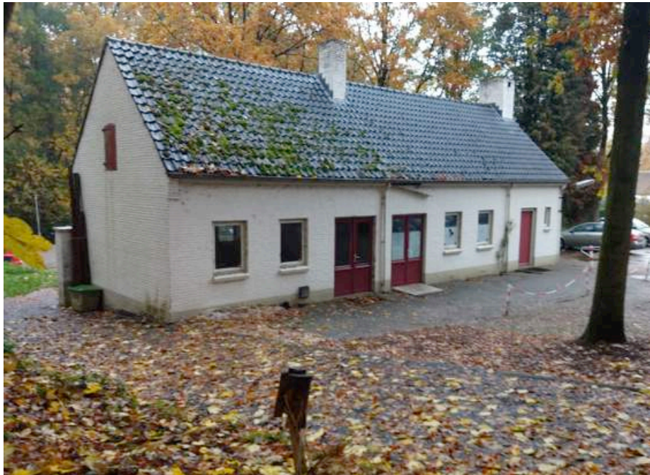
Figuur 5 Het te slopen gebouw op de nieuwbouwlocatie van het CvDB (ook weergegeven in figuur 3). Alleen deze woning in het plangebied heeft potentie als verblijfplaats voor steenmarter.
