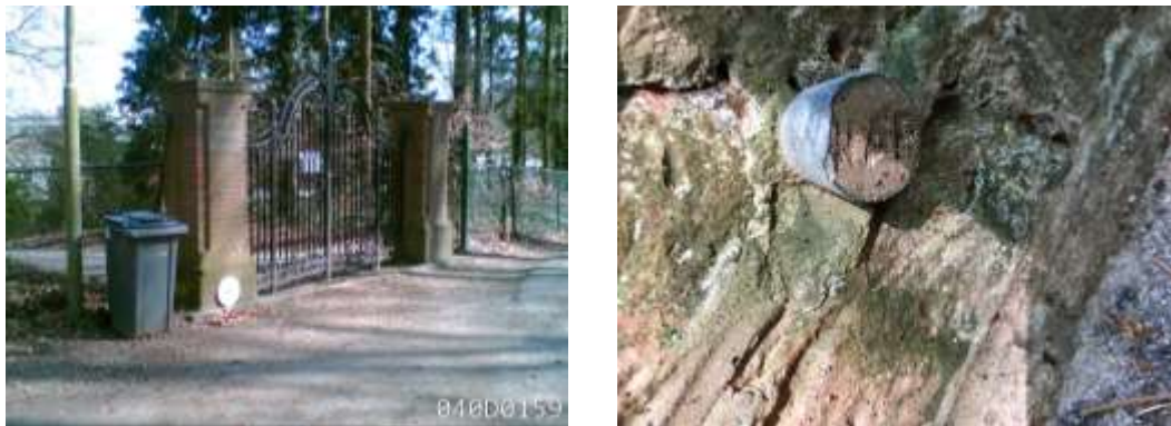
Figuur 10: Peilbout op hekpaal (in cirkel) van de toegangspoort met detail: meetdatum 23-5-2011
