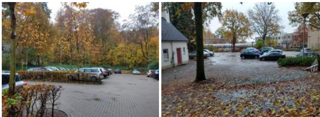
Figuur 4 Locatie van werkzaamheden Centrum voor doof-blinden in 2018. De bomen op de twee aangrenzende parkeerterreinen zullen worden gekapt en het witte gebouw met dakpannen (links op rechter foto) wordt gesloopt.
