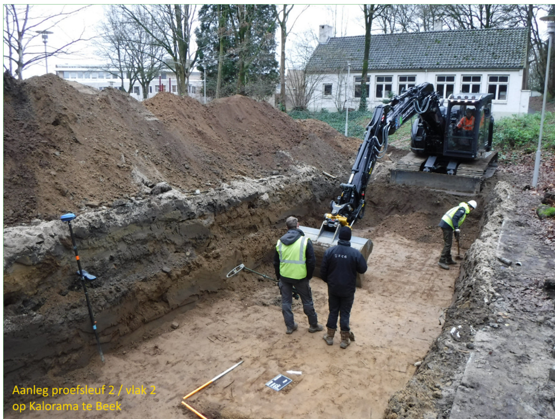
Afb. 3.2: Aanleg van proefsleuf 2.
