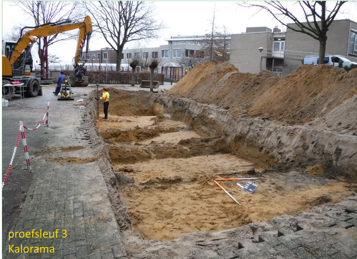
Afbeelding 3.7: Zicht op werkput 3 / vlak 1 richting noordoosten. De werkput wordt gekruist door diverse kabels en leidingen (daar waar het zand als een dammetje / rug gehandhaafd is).
