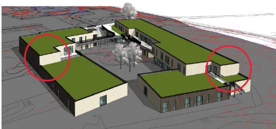
Figuur 3 Zicht op de nieuwbouw vanaf de noordkant naar het zuiden. In rood is de ligging van de stookruimtes weergegeven.
