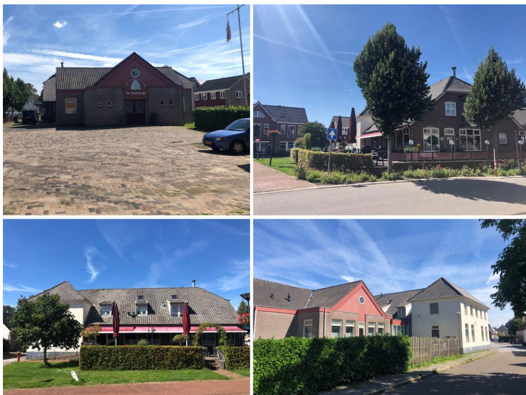
Foto's bestaande situatie
