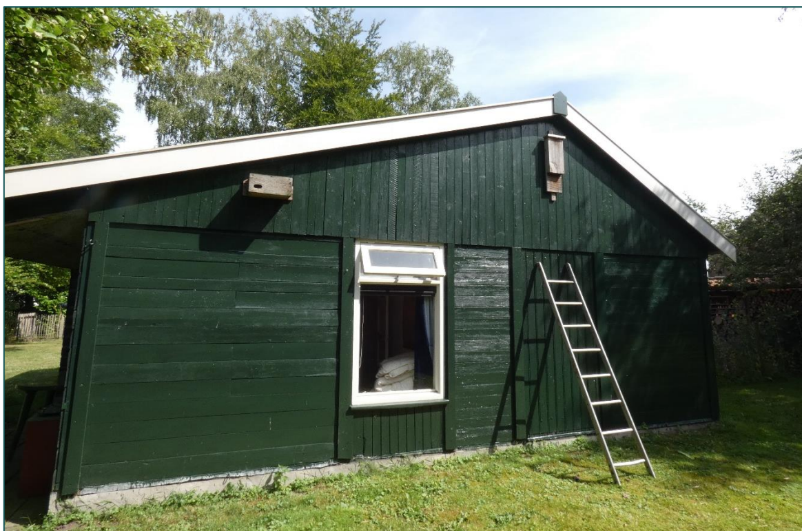
Figuur 2 De bebouwing bestaat uit houten wanden. Aan de kopgevel hangen een gierzwaluwkast en een vleermuiskast.
