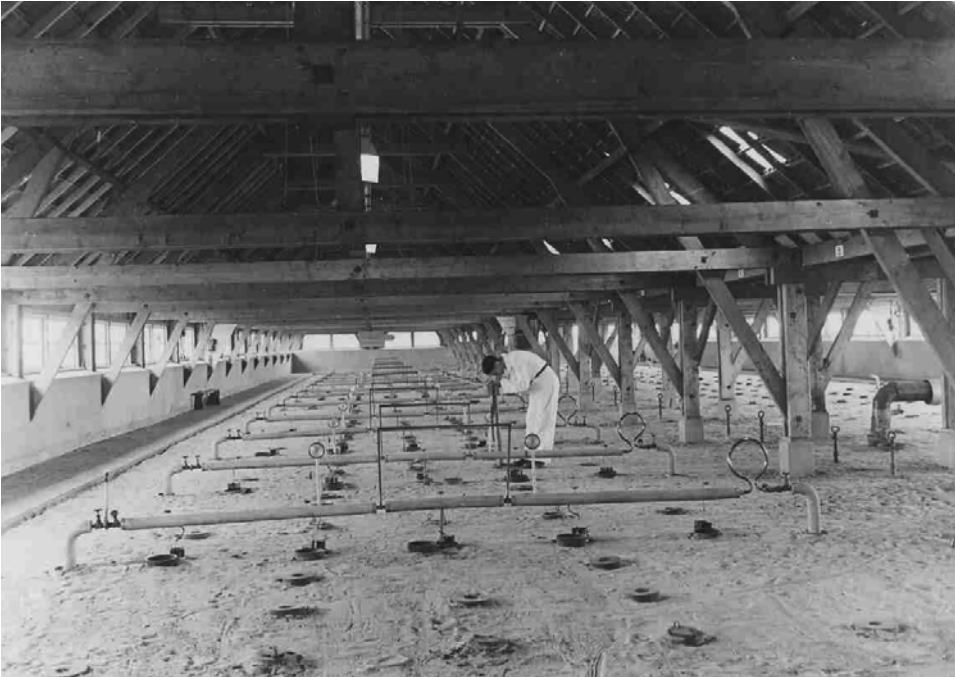
Oliestookinrichting van de steenfabriek De Ooij (Regionaal archief Nijmegen)
