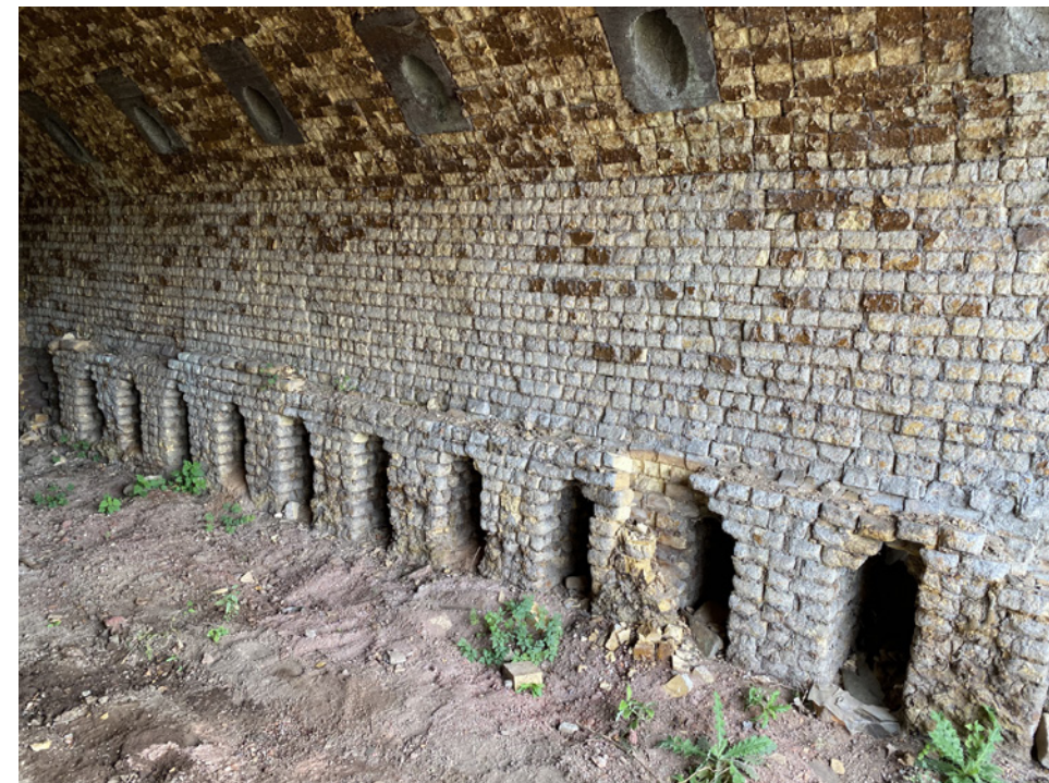
Een stookkamer waarbij in het gewelf de stookgaten te zien zijn. De stoker kon het vuur in de oven voeden door kolen of later olie toe te voegen. De gaten bij de grond werden 'fietsenrekken' genoemd en zorgden ervoor dat warme of koude lucht van de ene naar de andere kamer kon doorstromen
