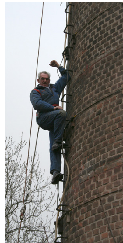
Detailbeeld van de schoorsteen bij de restauratie in 2006. (www.steenennatuur.nl)
