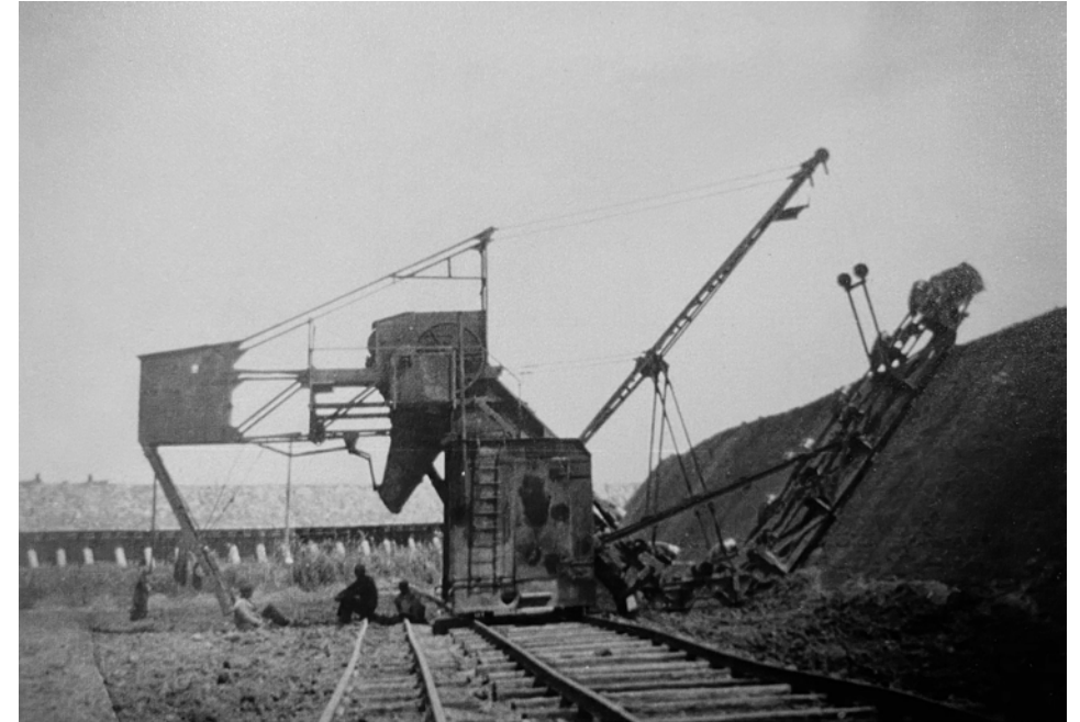
Een baggermolen aan het werk vlak bij Steenfabriek De Ooij (De Steenmakers / Fotocollectie Wim Ebben)
