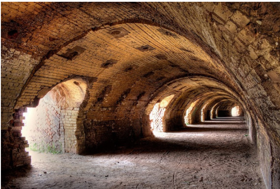
De bakplaats van een ringoven met links de poorten waar de stenen konden worden in- en uitgeladen (wuxtiple.blogspot.com/2013/06/a-story-of-brick-tile-pipe-making-in.html)
