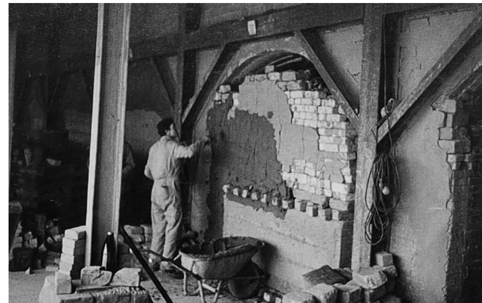
Het dichtsmen van de poorten op steenfabriek De Ooij (De Steenmakers / Fotocollectie Wim Ebben)
