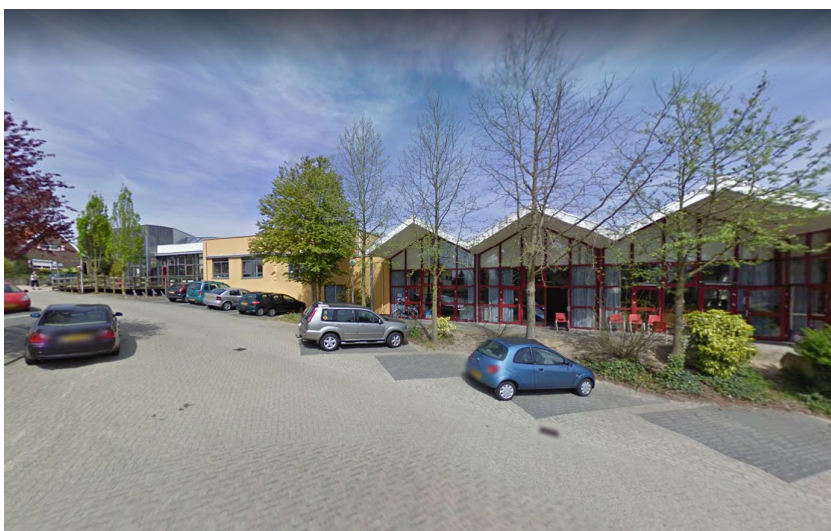
Zijkant dagbestedingsgebouw Zevenheuvelenweg 16 (richting het westen)
