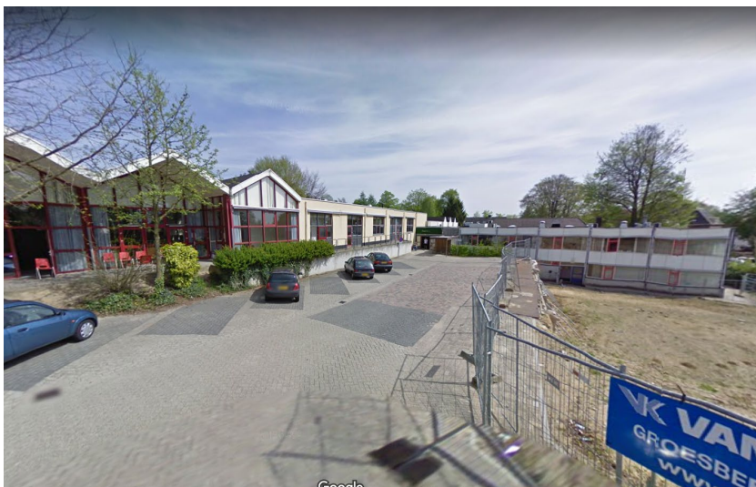
Zijkant dagbestedingsgebouw Zevenheuvelenweg 16 (richting het oosten)
