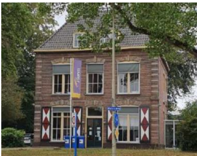
Afbeelding 2.2: Bestaande en te behouden kantoorvilla gezien vanaf de Molenweg, richting het westen.
