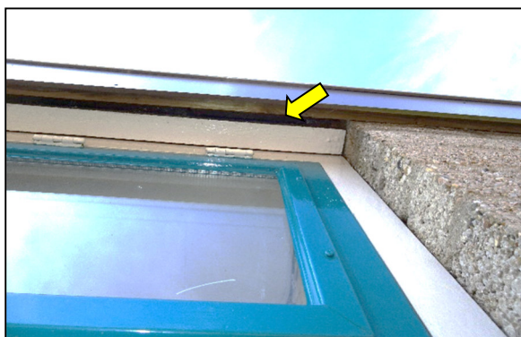
Figuur 7. Voorbeeld van opening tussen kozijn en boeiboord
