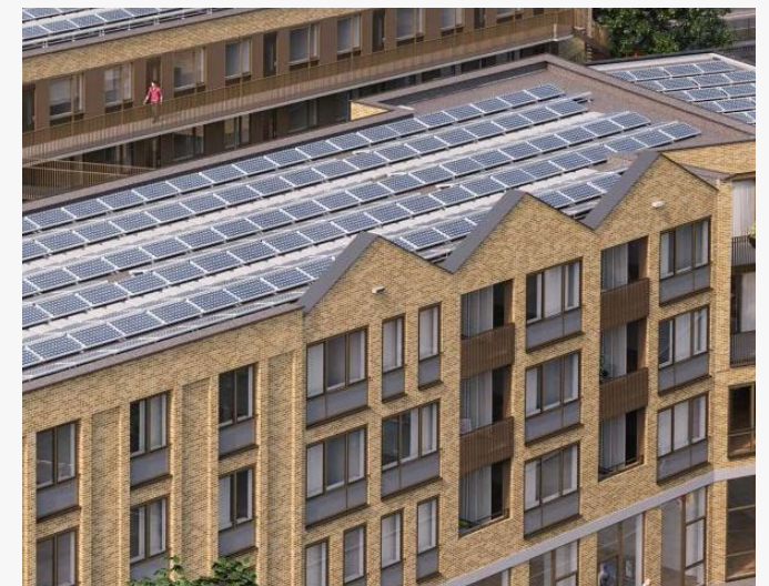
Zonnepanelen verscholen achter dakopstand
