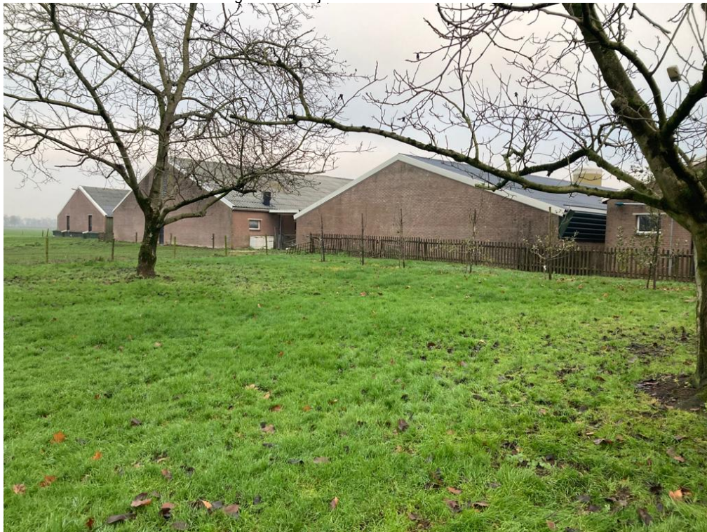
• Afbeelding 21: achterzijde varkensstallen
