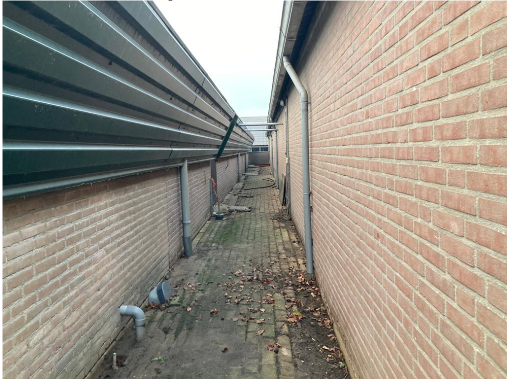
• Afbeelding 5: ruimte tussen de stallen met luchtinlaat
