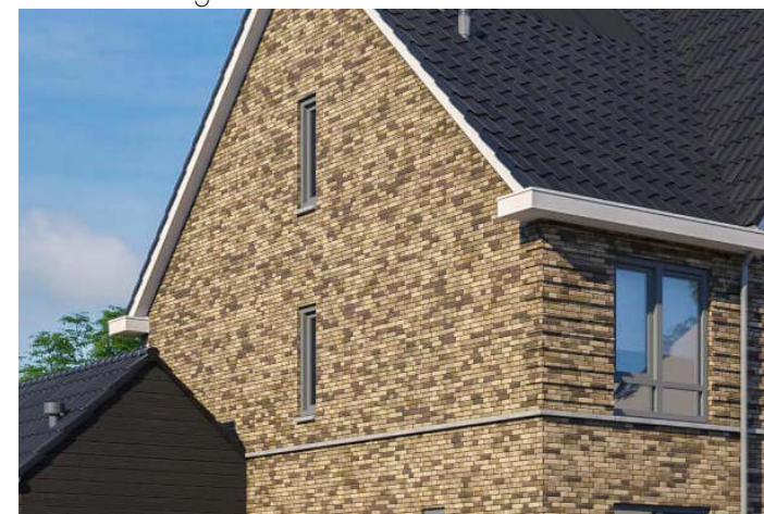
► Horizontale accenten in gevelbeeld
