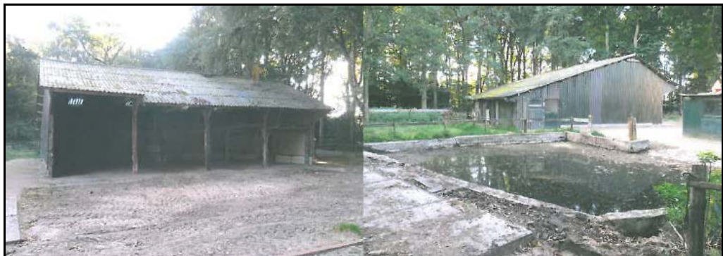
Huidige situatie zuidoostelijke schuur (bron: DENC, oktober 2013)
