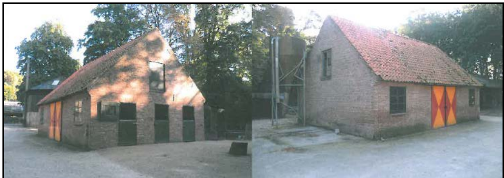
Huidige situatie noordoostelijke schuur (bron: DENC, oktober 2013)
