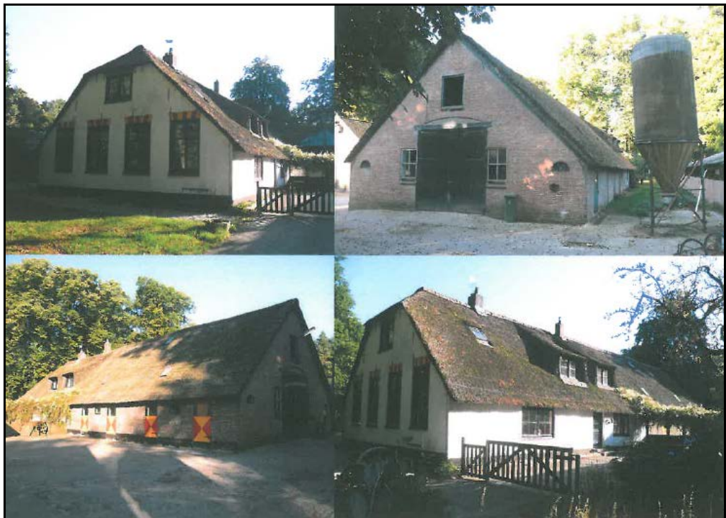
Huidige situatie woonhuis en deel (bron: DENC, oktober 2013)
