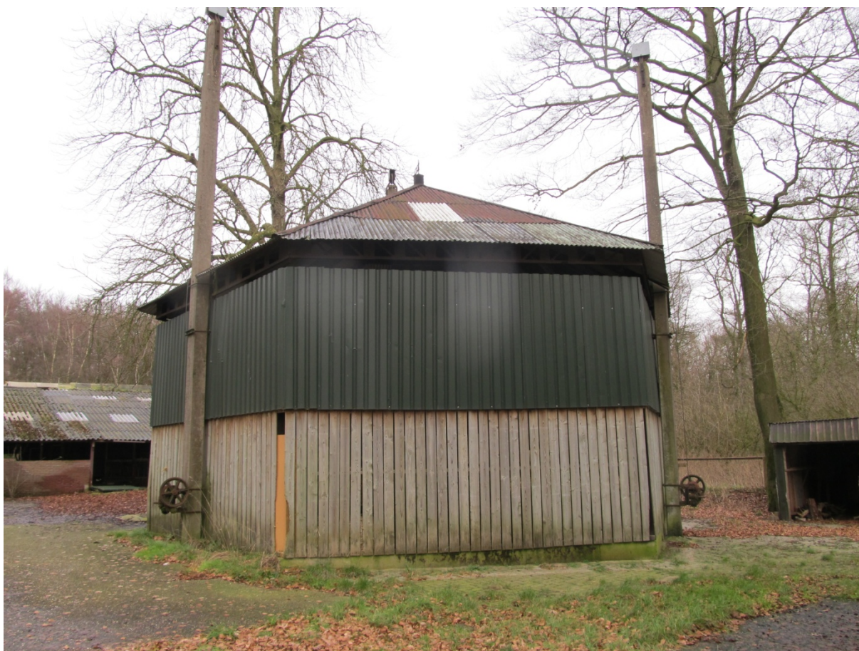
Hooiberg H met houten en golfplaten wanden en golfplaten dak
