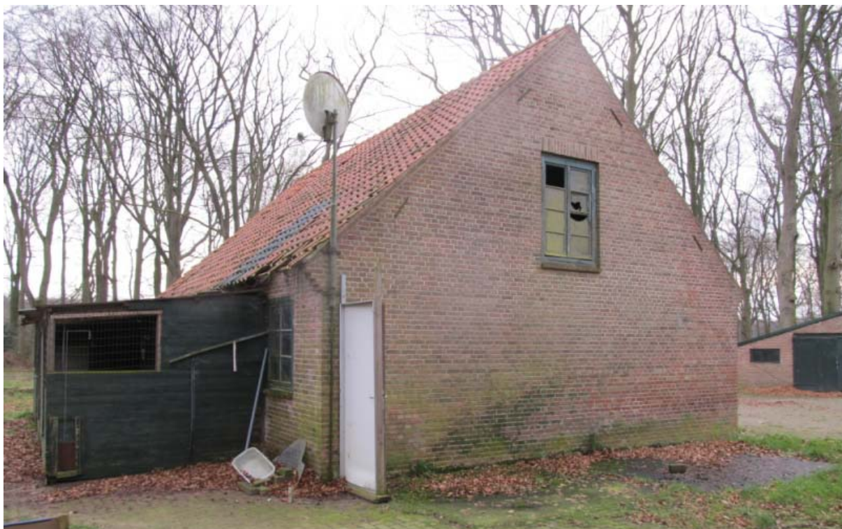
Bakstenen schuur S3 met houten uitbouw aan de oostzijde
