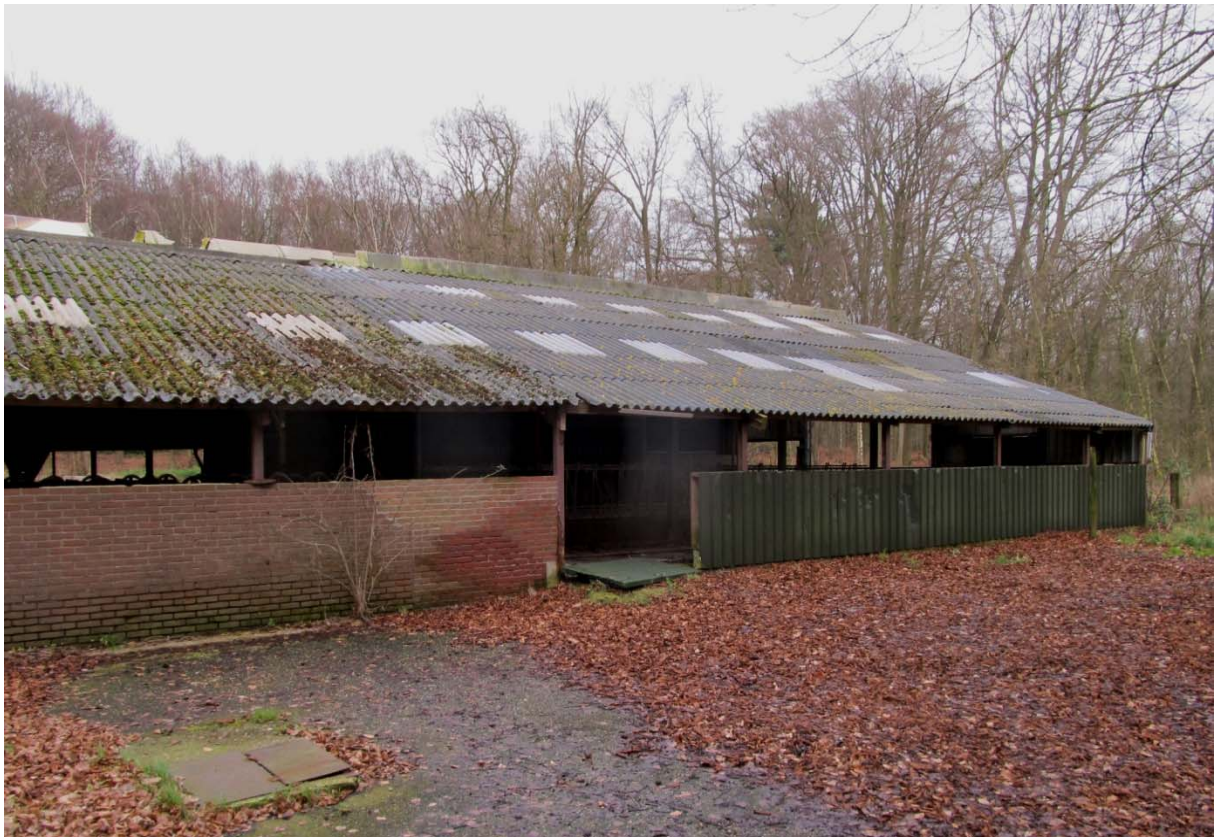
De ligboxenstal (S1) is een van de gebouwen die volgens de plannen zal worden gesloopt (IW)
