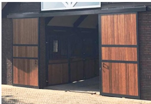
Dubbele staldeuren hout
