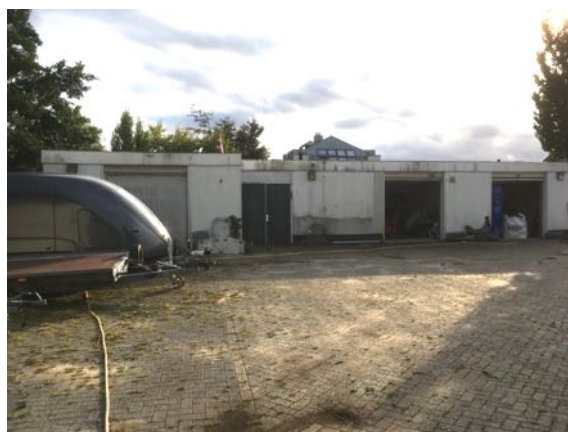
Figuur 6. Noordzijde te slopen loodsencomplex.
