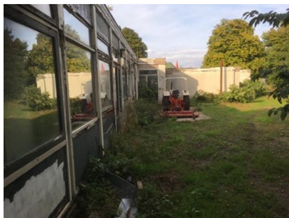
Figuur 4. Oostzijde te slopen loodsencomplex.
