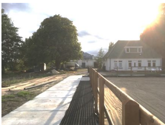
Figuur 7. Plangebied in zuidwestelijke richting gezien.
