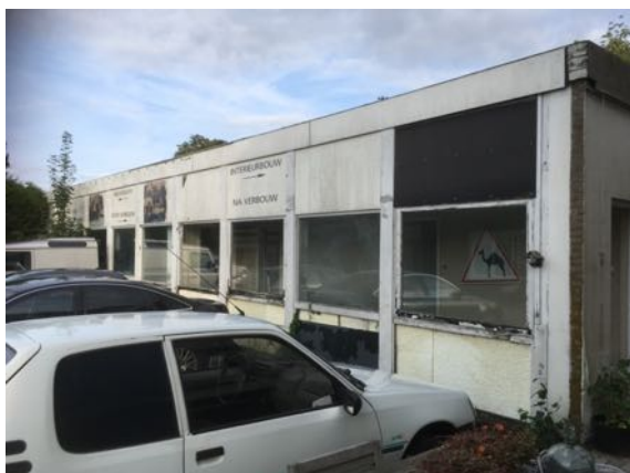
Figuur 3. Westzijde te slopen loodsencomplex.
