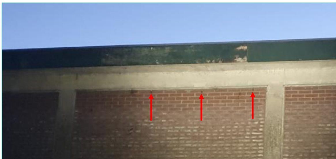
Figuur 3.4 Foto van de gebruikte ingangen naar het kraamverblijfplaats aan de westzijde van het hoofdgebouw.
