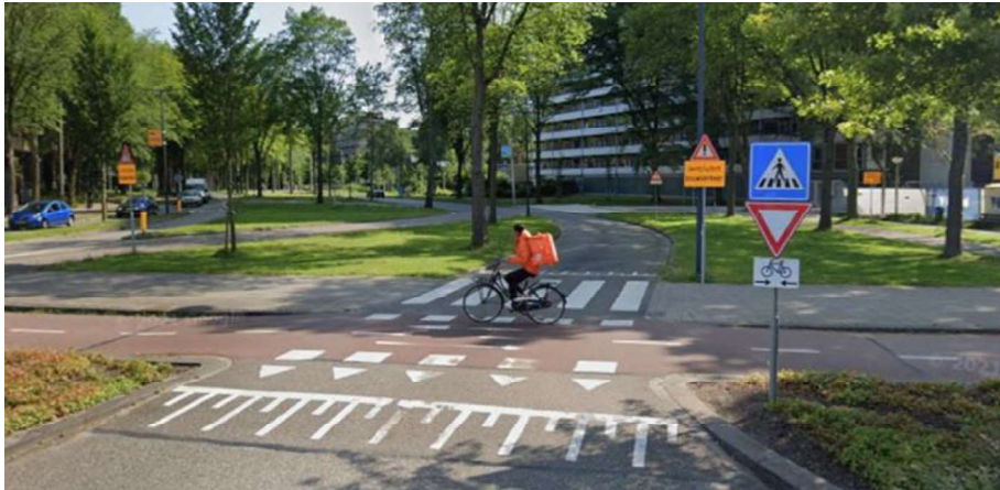
Foto 5.10: Voorbeeld tweerichtingen fietsoversteek met asmarkering extra bebording en snelheidsremmende maatregel (oude situatie Nieuwlandplein Delft)
