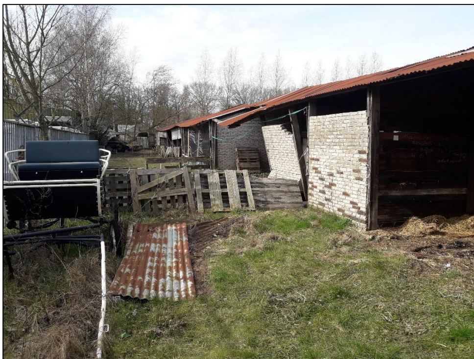
Foto 7: Zicht op zuidelijk deel onderzoekslocatie vanuit zuidoostelijke richting.
