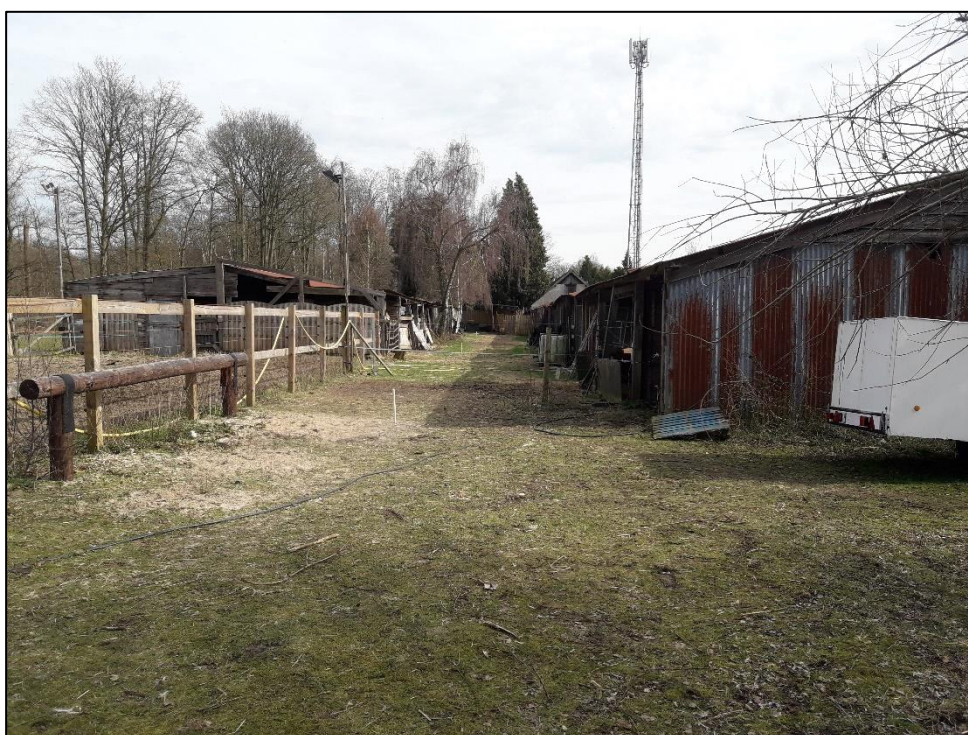
Foto 4: Zicht op onderzoekslocatie vanuit westelijke richting.
