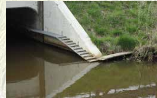
Kleine, niet zwemmende dieren en amfibieën gebruiken de ecoduiker met een droge looprichel om de weg veilig over te steken.
