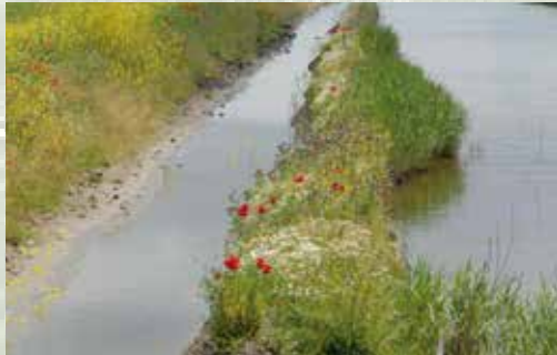
De natuurvriendelijke oever met voorgrepel vormt mede door het flauwe talud een beschutte leefomgeving voor insecten, kikkers, padden, kleine zoogdieren en vissen.
