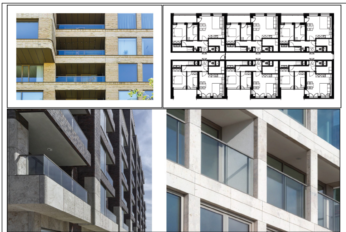
Figuur 4.6: Balkons met verhoogde of gesloten borstwering en geluidsabsorptie ('State' in Amsterdam, ZZDP architecten)
