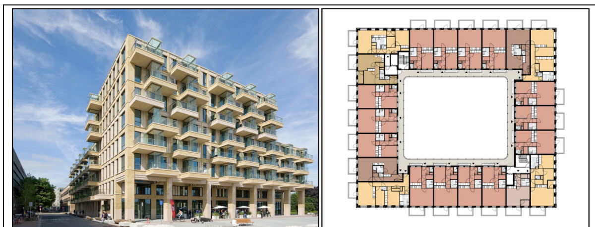
Figuur 4.7: Geheel verglaasde buitenruimte, gesloten balkons met ventilatie ('Square' in Amsterdam, LEVS architecten)
