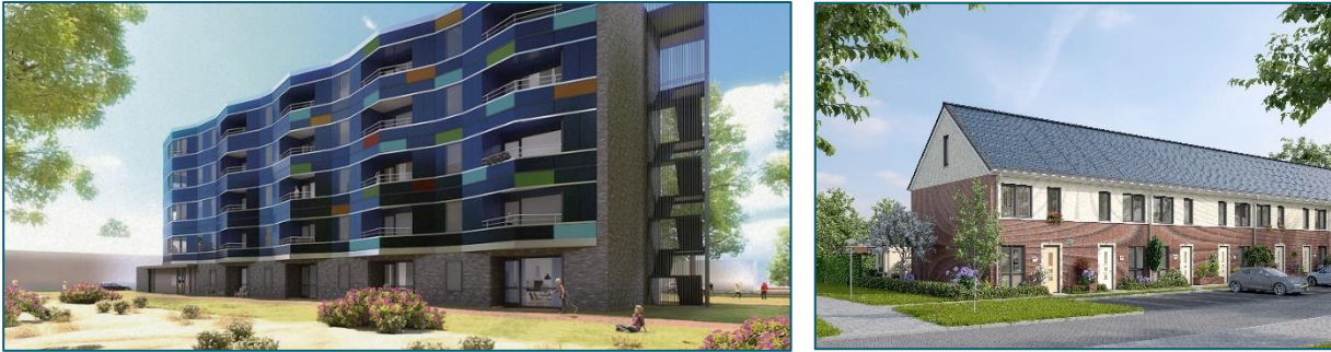
Figuur 12 – geïntegreerde PV-panelen (MyEnergySkin) en grondgebonden NOM-woningen in Boekel
