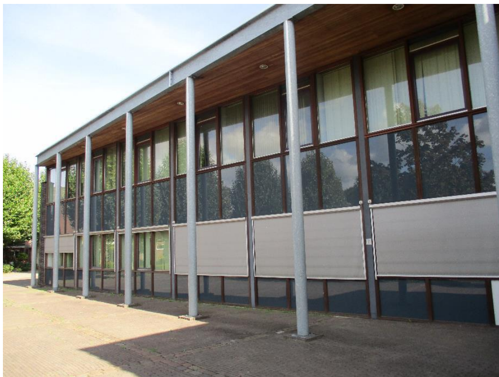
Figuur 1 De planlocatie is gelegen aan Het Anker 2 te Muiden en betreft een oud gemeentehuis. Het pand is opgetrokken uit een gemetselde, geïsoleerde spouwmuur en heeft een plat bitumen dak.
