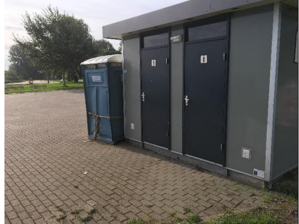
Foto D: toiletgebouw
