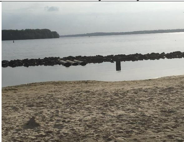
Foto Q: Buizen door strekdam
