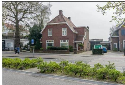
Figuur 6: Foto bestaande situatie woning Huizerweg 6-8
