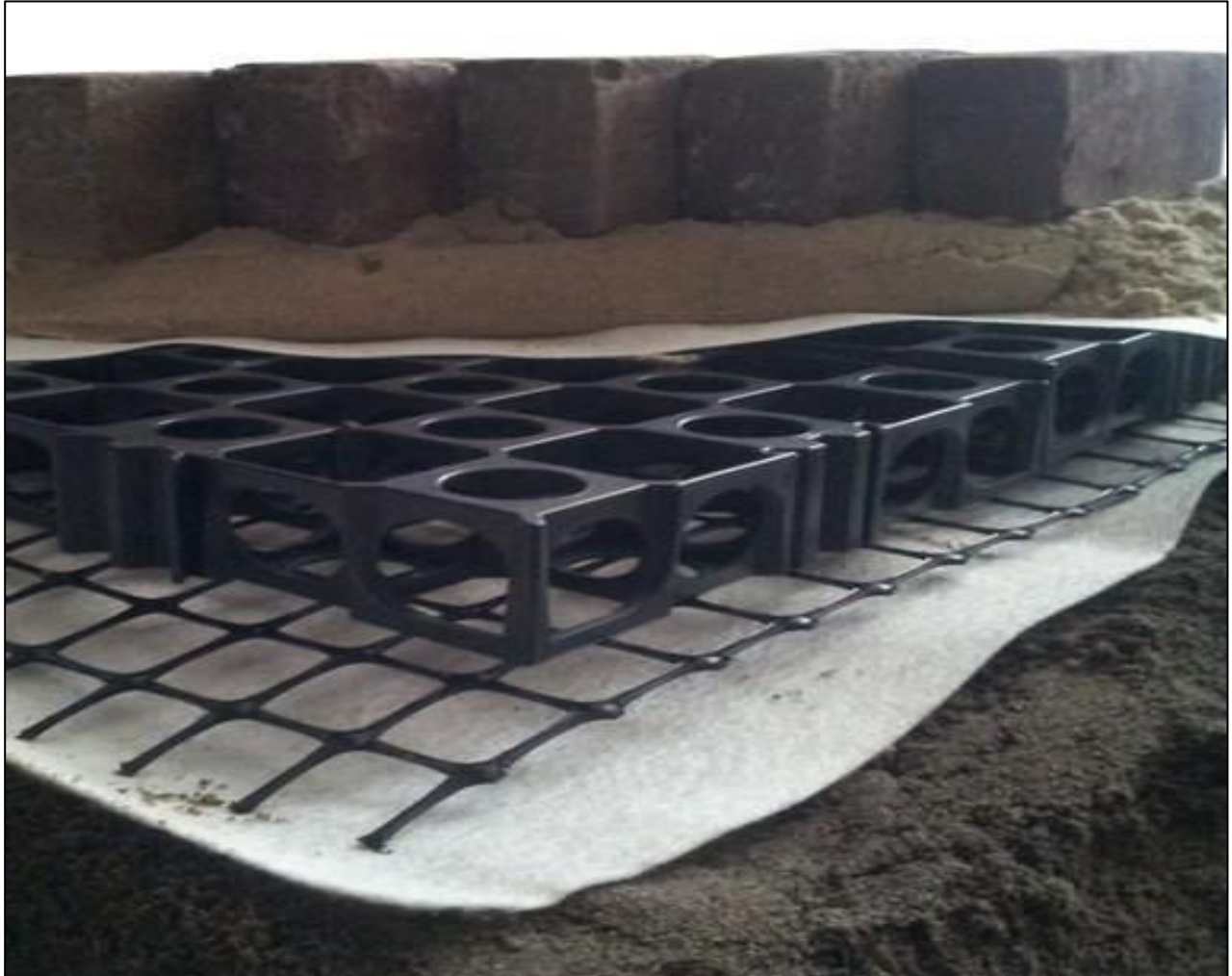
Afbeelding 4: voorbeeld van een sandwichconstructie
