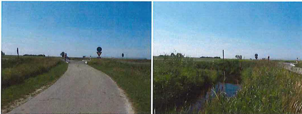
Foto 2 Impressie van de huidige oversteek ledyk met de te verleggen sloten.
