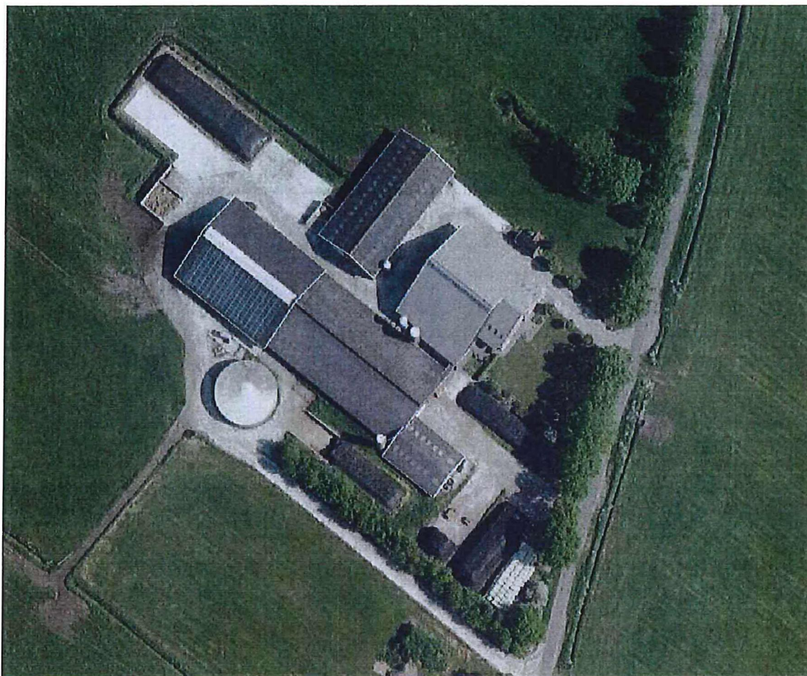
Luchtfoto huidige situatie ter plaatse. Bron: www.ruimtelijkeplannen.nl .
